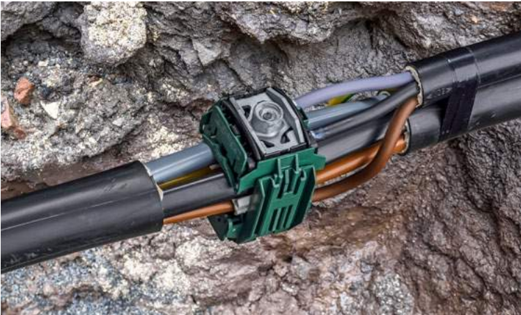
Bereitete Kabel für die Montage von SICOMPACT-Kabelabzweigklemmen.
